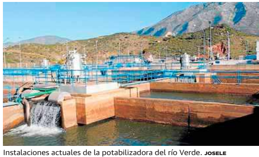
Instalaciones actuales de la potabilizadora del río Verde. JOSELE
