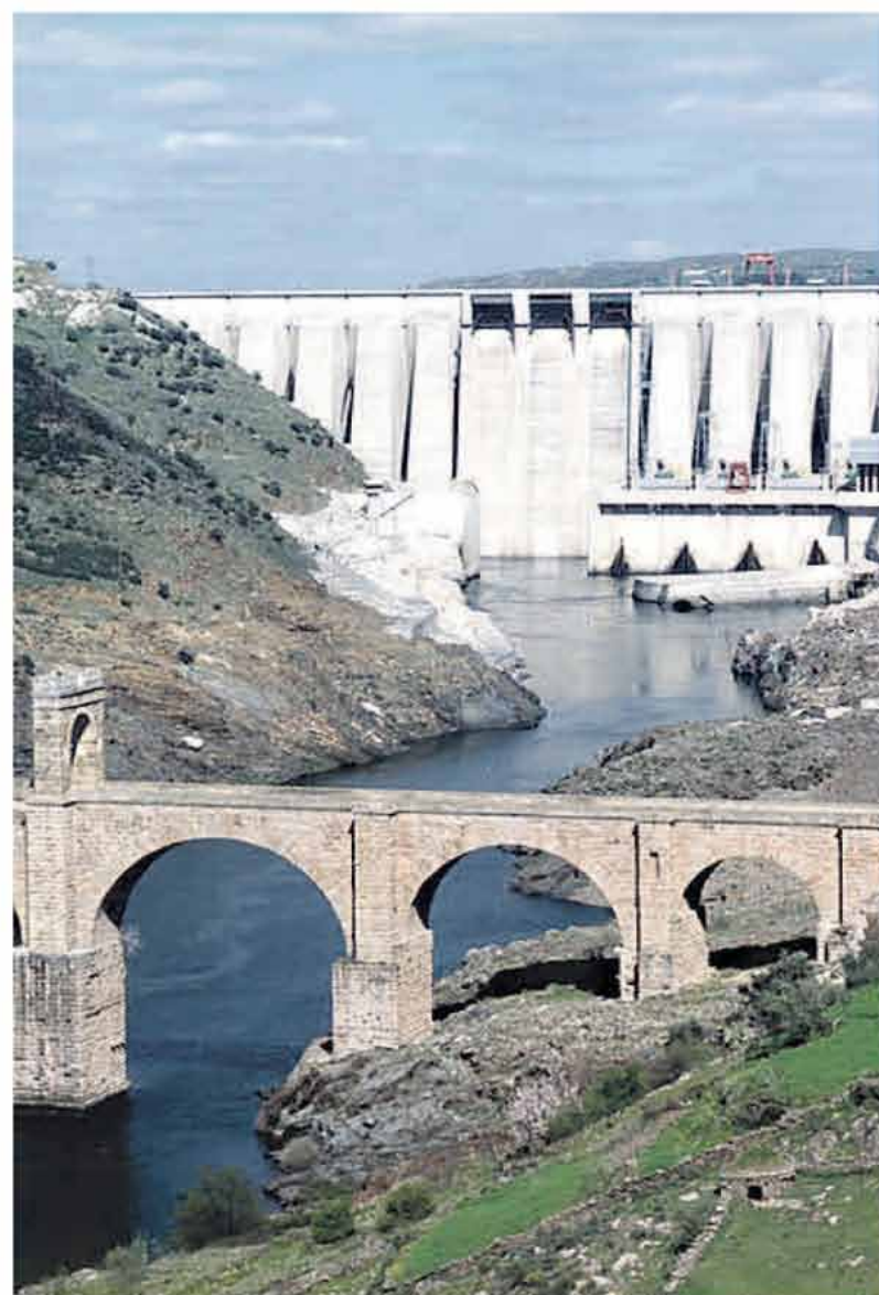
El mayor deterioro se registra en rehabilitación. eE
