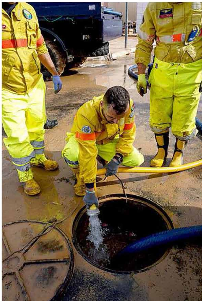
Los operarios inyectan agua a presión para liberar el alcantarillado. EP
