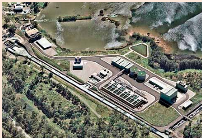
Complejo de tratamiento de agua potable de Prospect en Australia, donde trabajará Acciona.
