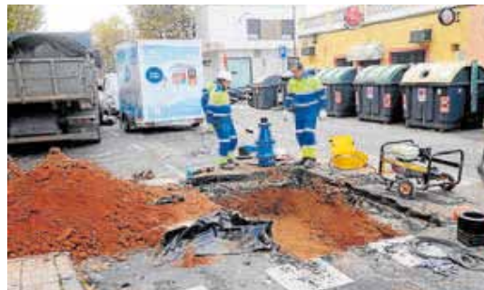
Las máquinas de Aqualia trabajan en la calle Isidro Pacense. C. MORENO
